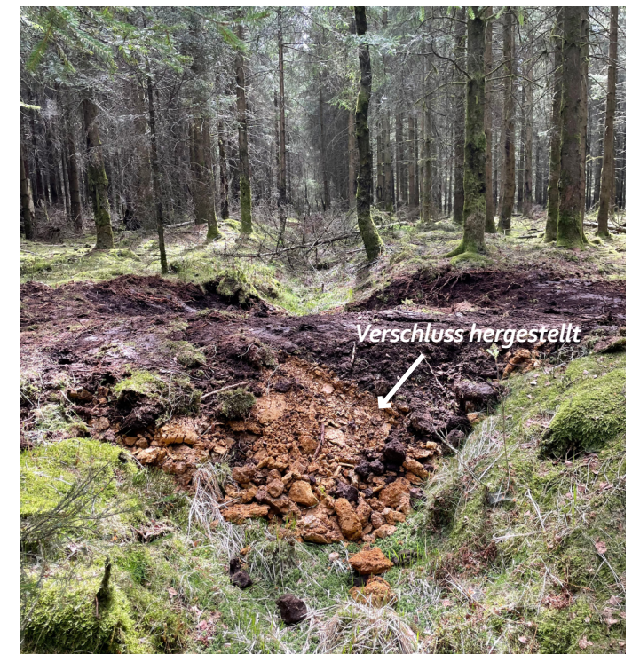
Vorher-Nachher : Verstopfung eines Waldentwässerungskanals im Bois Mousseux Est., Spa (Source PNS)
