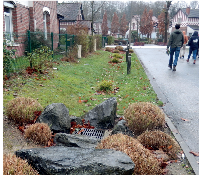
Versickerungsgraben in Douai - Ein Versickerungsgraben ist ein begrünter Graben, der die Versickerung fördert und das Wasser lenkt.
