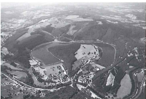
Vue aérienne des bassins de Coo
