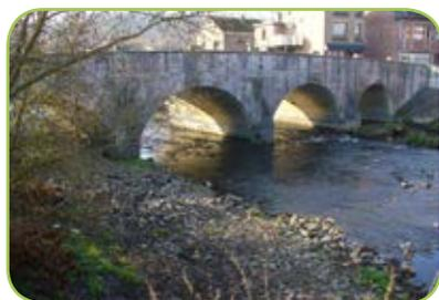
A cette occasion, Patrice Lefèbvre, nous rappelle que les archives remontent à 1567 pour l'année de construction du 1<sup>er</sup> pont (il s'agit probablement du remplacement d'un ouvrage déjà existant). Il fut réparé en 1732 et en 1876 avant d'être gravement endommagé en 1944. Sa reconstruction démarra en 1957 pour prendre fin en mai 1958. Ce pont voûté, en moellons, composé de 5 arches, fut immédiatement désigné comme «ouvrage d'art».
