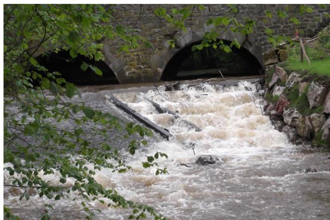
Aménagement d'une échelle à poissons sur le seuil de l'Eau Rouge à Stavelot, avec remplacement du mur de berge gauche juste en aval (STP Province Liège)
